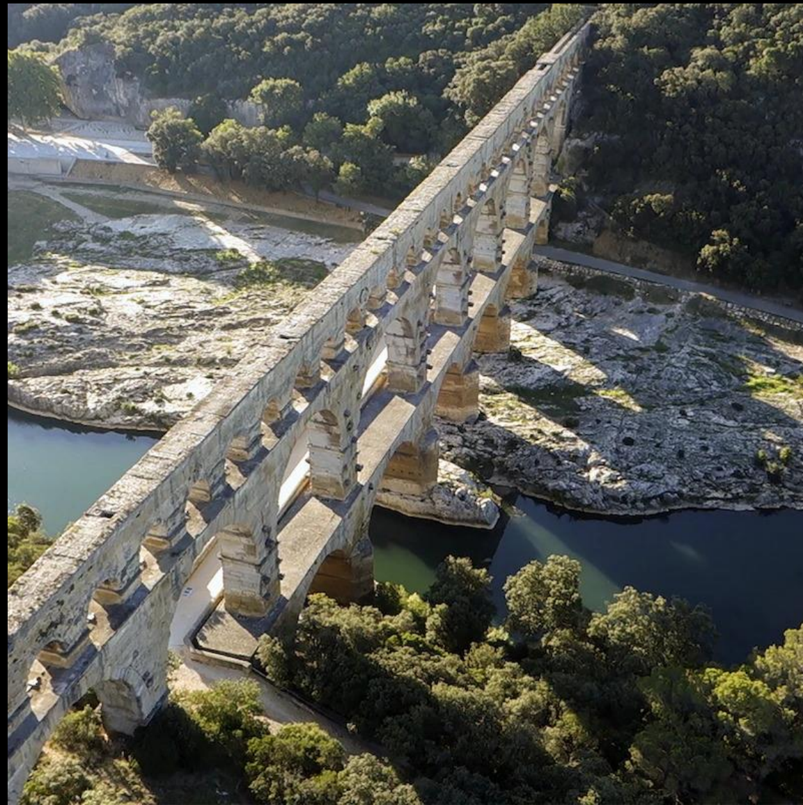
Vue de dessus grâce à un drone
