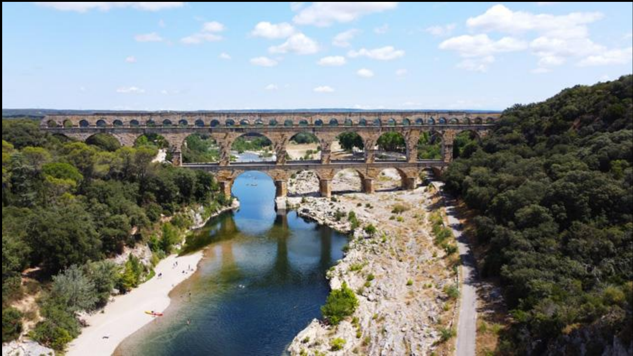
Vue de dessus grâce à un drone
