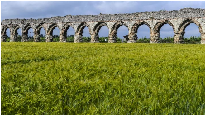
L'aqueduc du Gier
