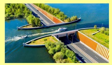
Le pont Cacor et l'aqueduc Veluweemer permettent la circulation des bateaux - même au-dessus d'une rivière ou d'une autoroute!
